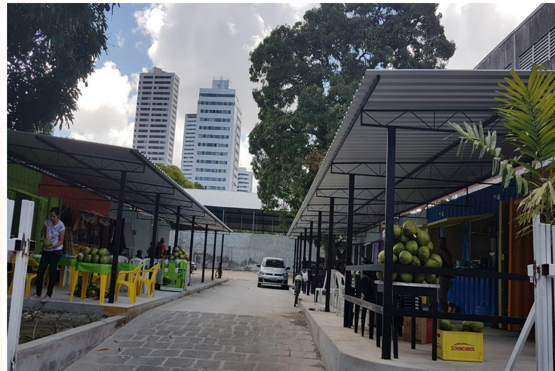
Nova instalação e infraestrutura para as barracas
