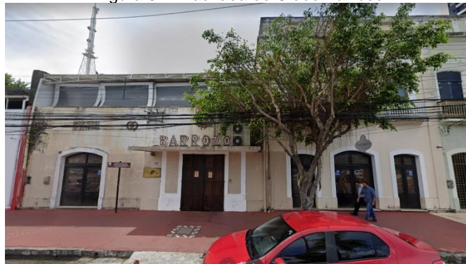
Figura 51 - Fachada do Clube Barroso
