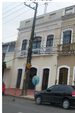
Figura 53 - Detalhe da fachada
