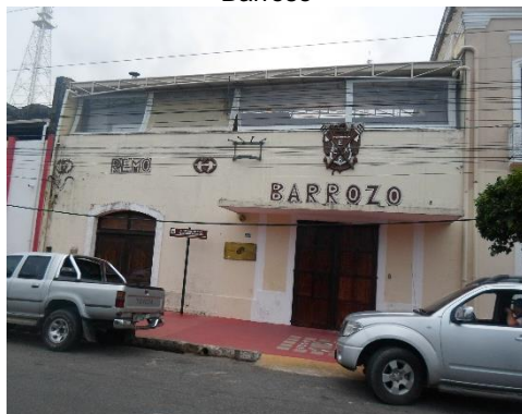
Figura 52 - Detalhe da fachada do Clube Barroso
