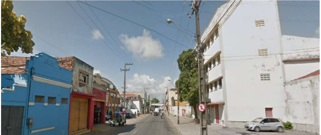
Figura 03 - A via de acesso ao Empreendimento, Rua Imperial, obedece aos parâmetros exigidos pela Engenharia de Tráfego, apresentando faixas de rolamento e calçadas. Encontra-se sinalizada e em boas condições de tráfego. Favorece condições físicas à localização dos acessos de entrada e saída de veículos e de pedestres.
