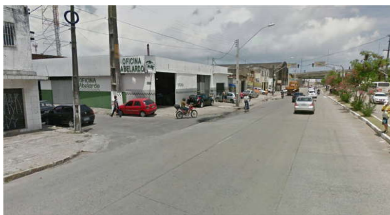
Int-03: Interseção da Av. Sul/Rua Lourenço de Sá (vista da Av. Sul)
