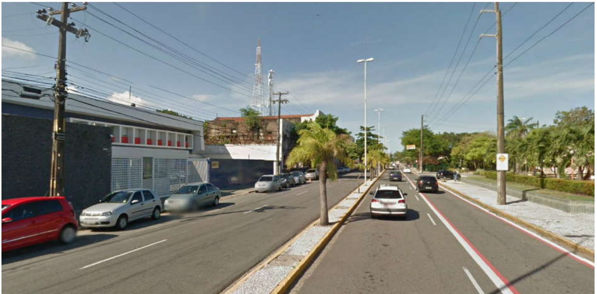
Figura 04: Vista parcial da Rua da Aurora – Terreno objeto encontra-se à esquerda.
