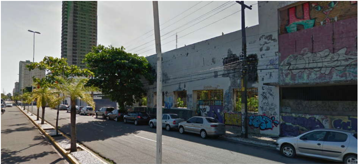
Figura 03: Vista parcial da Rua da Aurora – Terreno objeto à direita.
