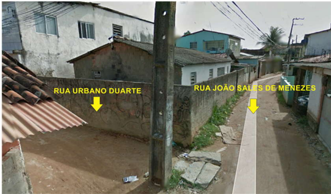
Figura 07 – Ruas João Sales Menezes e Urbano Duarte: Ausência de pavimentação.
