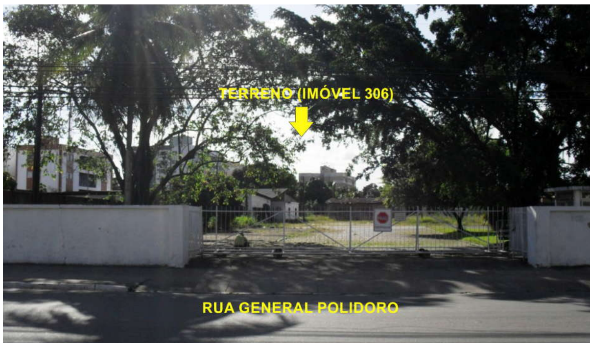
Figura 02 - Vista do Terreno (objeto de análise). Apresenta-se com uma topografia plana, sem alagamentos e com cobertura vegetal. Há edificações remanescentes de usos anteriores e que serão demolidas para a implantação do Empreendimento.
