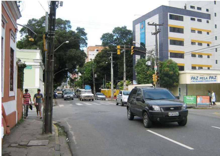
Cruzamento da Rua Joaquim Nabuco com Rua Guilherme Pinto
